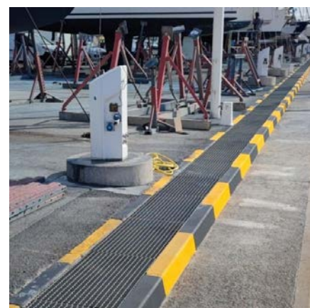
Caniveau de récupération des eaux de ruissellement et des effluents le long de l'aire de carénage © Port Leucate
